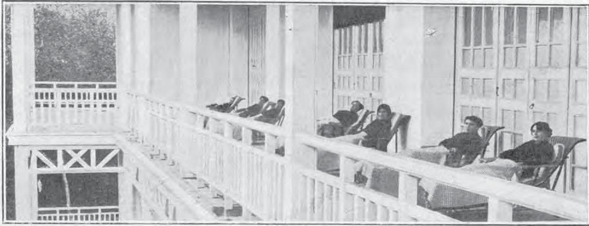
Vista parcial de una de las galerías exteriores para la cura de aire, correspondiente al segundo piso del edificio, que es el destinado á la sección de mujeres, siendo enteramente igual su distribución á los del primer piso, destinado á hombres.
