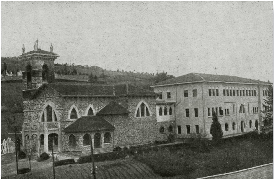
Noviciado de Zumarraga, Gipuzkoa
