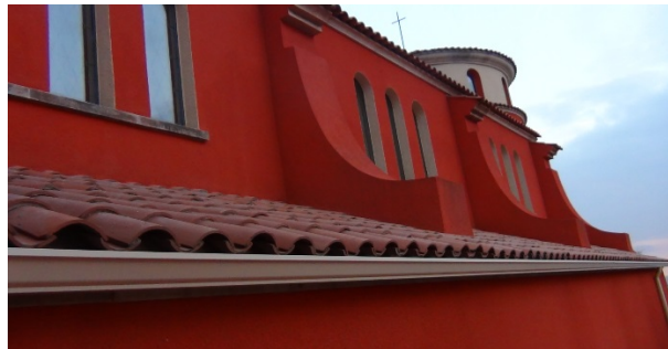
Vista exterior y parcial de la capilla
