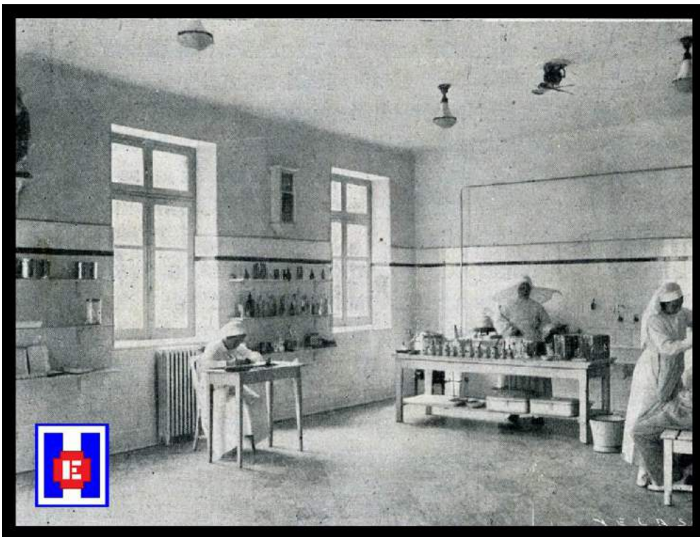
Imagen 38. Sala del Dispensario del Hospital María Cristina. Escuela Damas Enfermeras.
