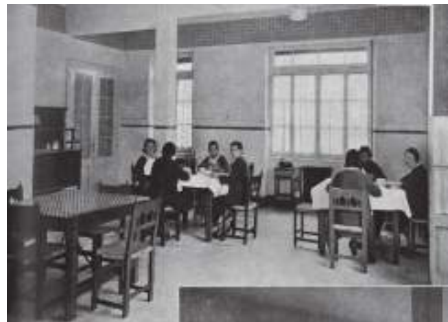
foto 80. Espléndido comedor de la Casa de Maternidad
