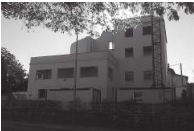
foto 81. Obras en 1986 en la Residencia San José
